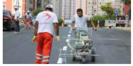
A.KAHVECİ MH ULUDAĞ CD YOL ÇİZGİ ÇALIŞMASI
