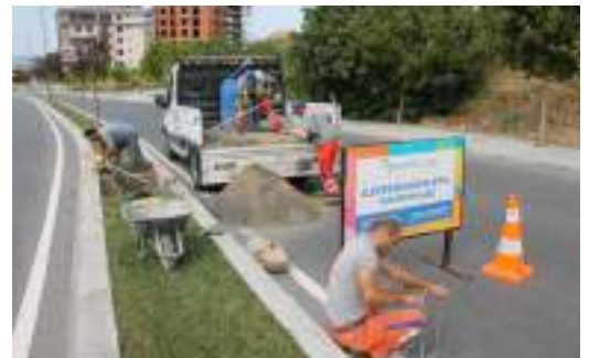
ELEKTRİK AYDINLATMA ÇALIŞMALARI
